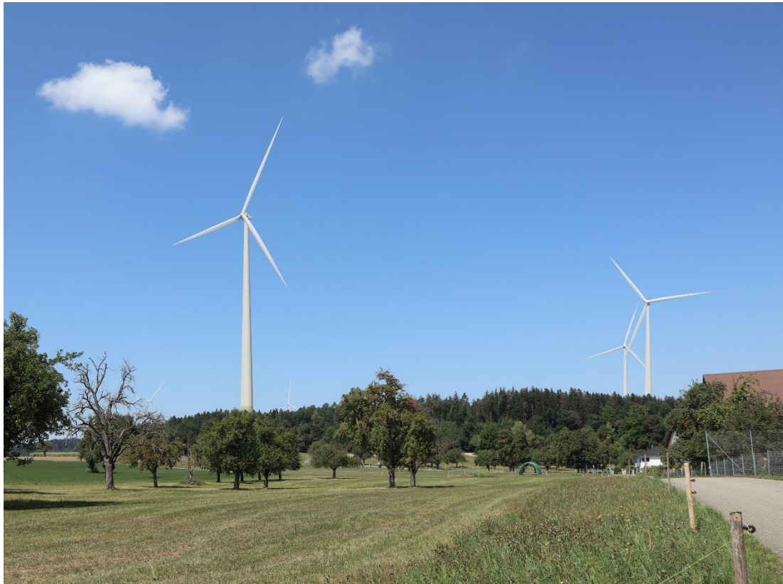
Enercon E160, Nabenhöhe 166 m
